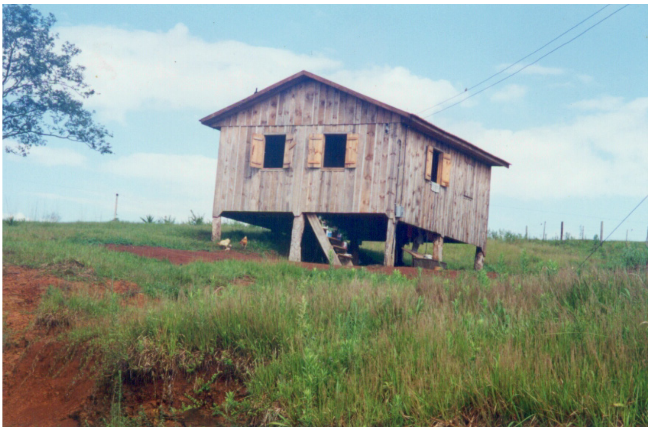
Construção da primeira casa – 1989.
