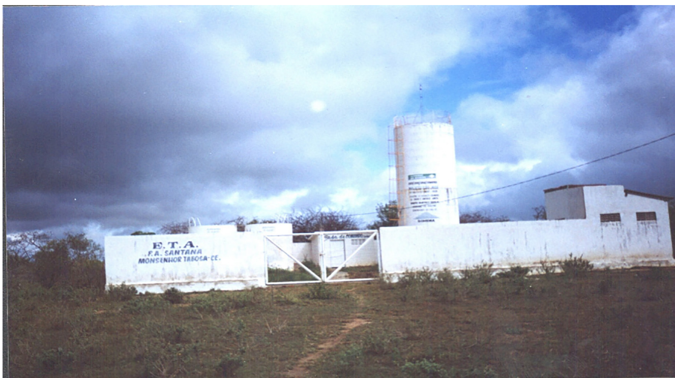
ETA - Estação de Tratamento de água. Fotos: Silvana Lima, Maio/2004.
